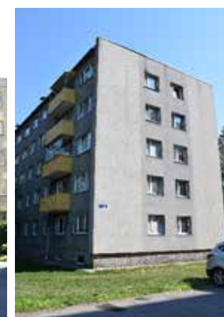
11. ábra A teljes homlokzat hőszigetelése; Végfali hőszigetelés (saját fotó)
