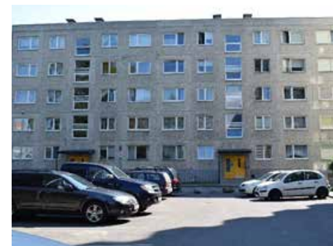
10. ábra Nagy arányban cserélt homlokzati nyílászárók nem felújított lakóépületen (saját fotó)
