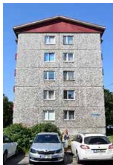
9. ábra Magastetővé átépített lapostetők (saját fotó)
